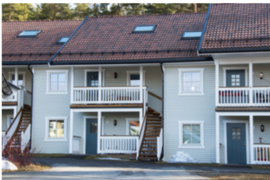
Tilsynsrapporten fra Asker kommune påpeker alvorlige feil og mangler.
