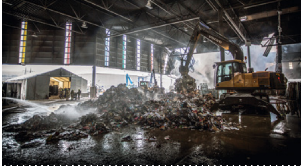
Foto: Oslo brann- og redningsetat Utrolig nok så ble skadene på bygning og maskineri ganske begrenset.
