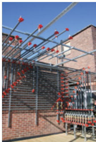
Rigg med sprinkleranlegg.
